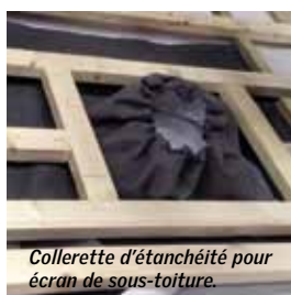
Collerette pare-vapeur d'étanchéité à l'air.
